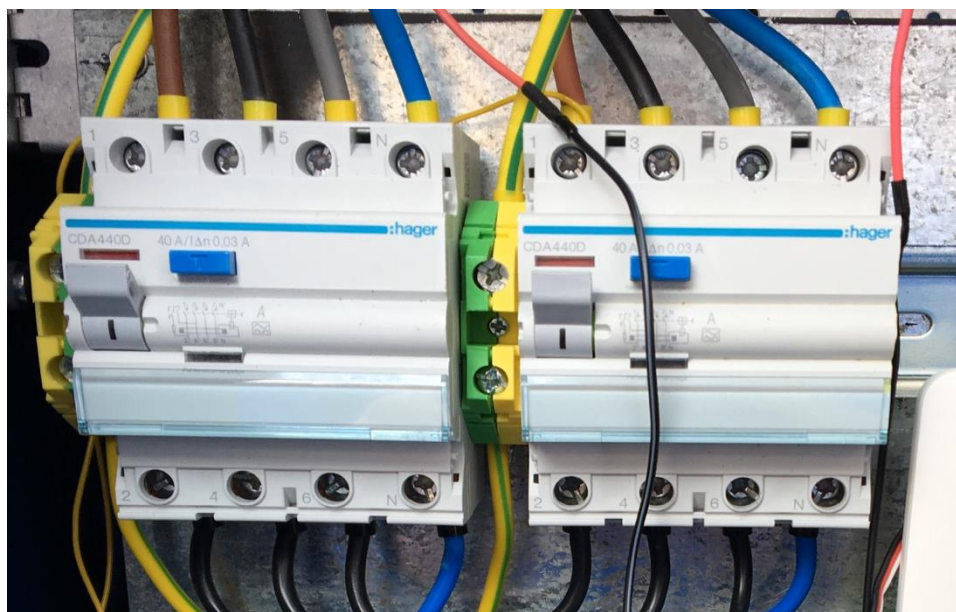
Obrázek 9: Sestavení proudových chráničů uvnitř stanice
