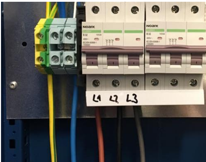
Obrázek 6: Zapojení vodičů v TN-S síti
