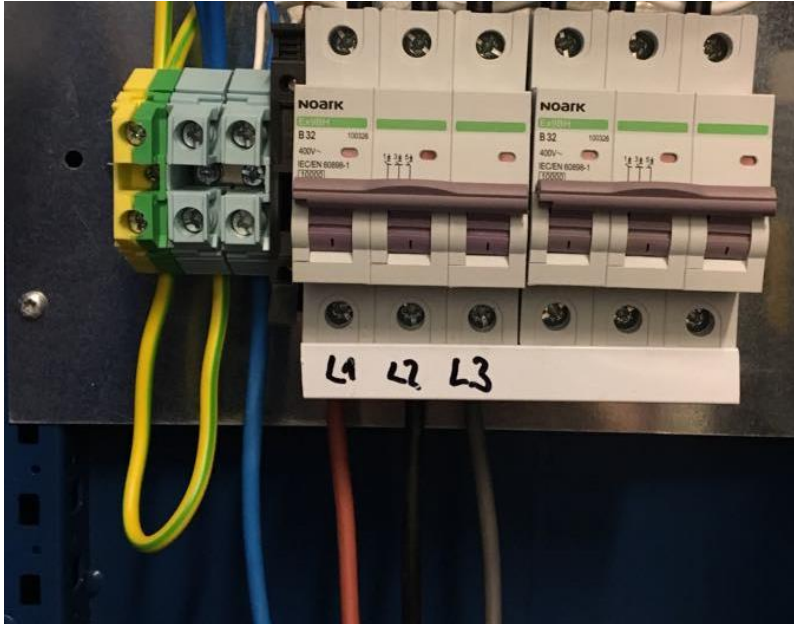
Obrázek 5: Zapojení vodičů v TN-C síti
