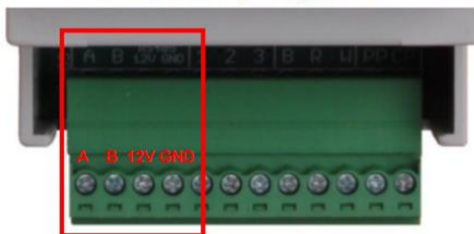
Svorkovnice řídicí jednotky ve stanici
