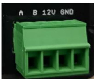
Svorkovnice vyhodnocovací jednotky v rozvaděči
